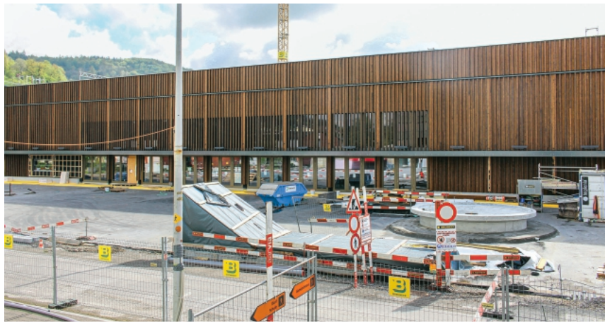
Die Holzfassade «in echt»: Das neue Zentrum nimmt Gestalt an
