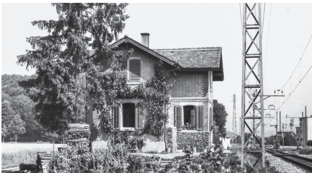
Das Bahnwärterhaus Seebli musste dem Gütergleisbau zum Amag-Areal weichen
