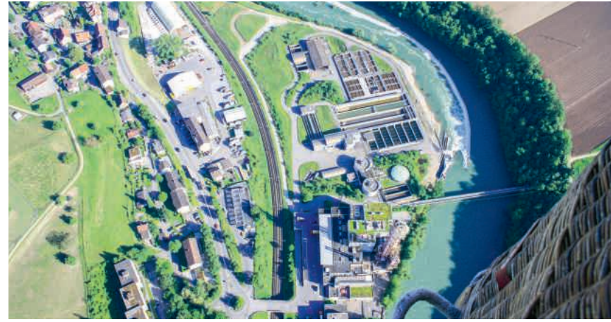
Der Laufäcker in Turgi mit Kehrrechtverwertungsanlage, Kläranlage und Merz-Areal (oben links), das der Gemeindeverband nun gekauft hat BILD: ZVG | FRANZ KILLER
