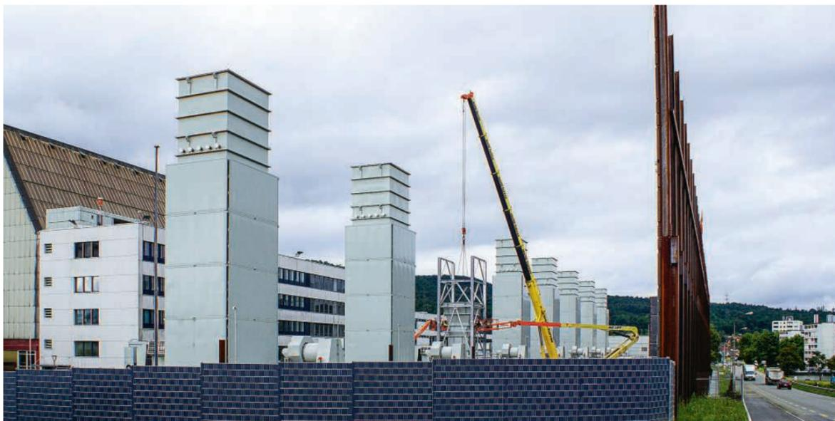
Sieben der acht mobilen Ölgasturbinen des Notkraftwerks in Birr wurden mittlerweile mit Schallschutzdämpfern nachgerüstet, sie dürften dadurch weniger Lärm verursachen als ursprünglich angenommen
