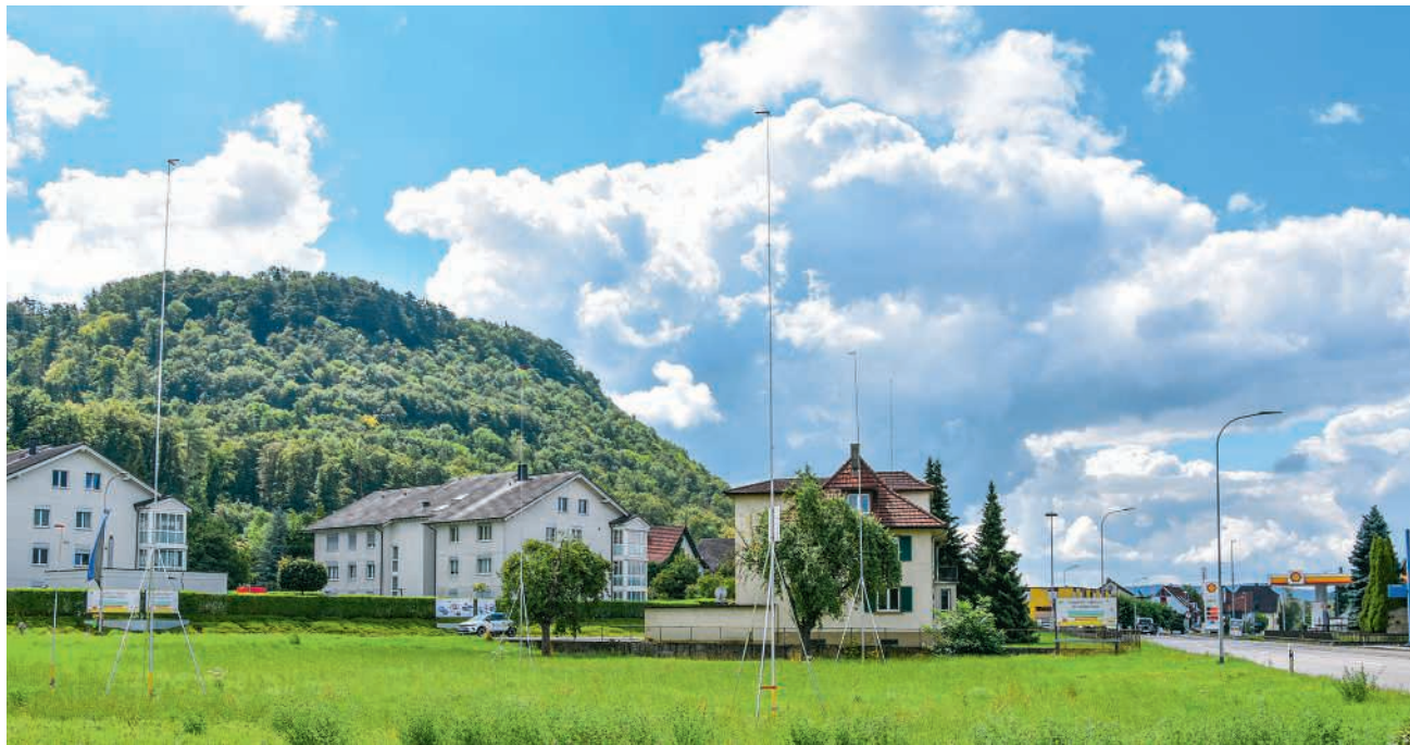
Aus der Perspektive des Nachbargrundstücks mit der «Rille»: Der geplante McDonald's zwischen Döttinger- (rechts) und Siggenthalerstrasse. Das leer stehende, gelbliche Mehrfamilienhaus wird abgerissen
