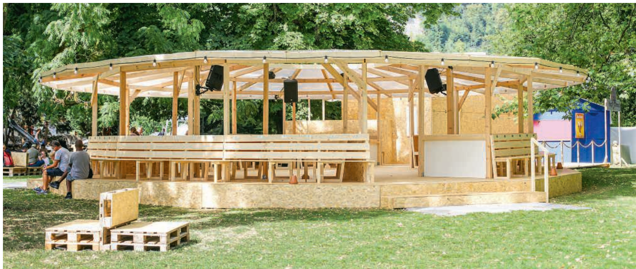
Fast wie der Entwurf: Der Pavillon «Kappi-Strand» im Kurpark (hier noch im Bau)
