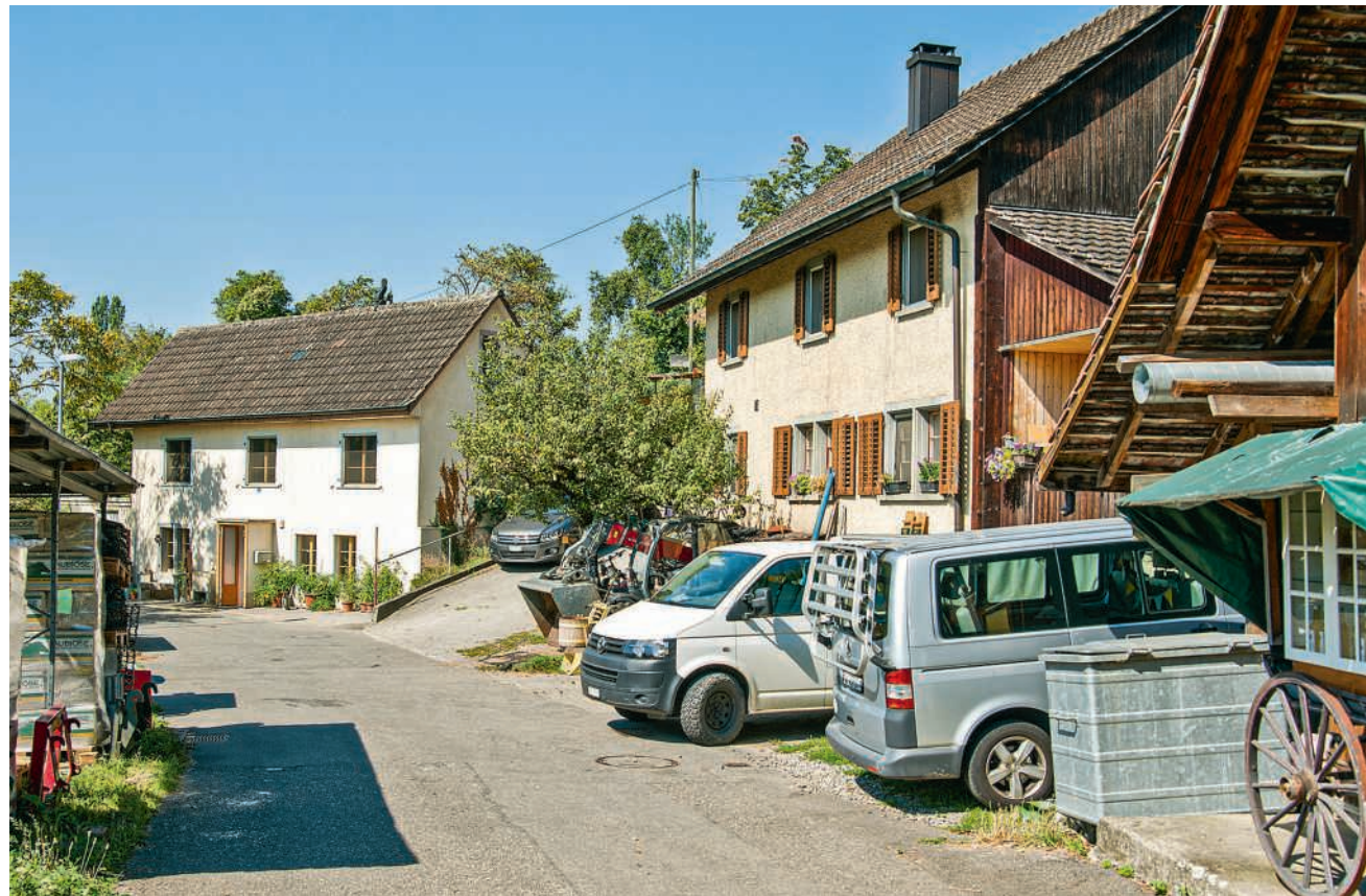
Die auf dem Bauernhof Bergstrasse 77 angebotenen tiergestützten Therapien sind mit dem Nein des Einwohnerrats zur baurechtlichen Spezialzone unmittelbar gefährdet - so dürfte beispielsweise für den Sandplatz (Reiten) eine Rückbauverfügung drohen
