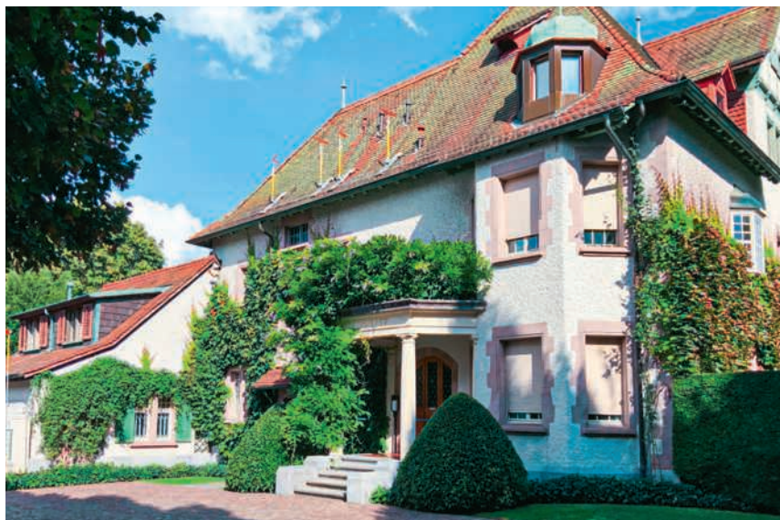
Wird umgebaut: Das Museum Langmatt mit Bauprofilen
