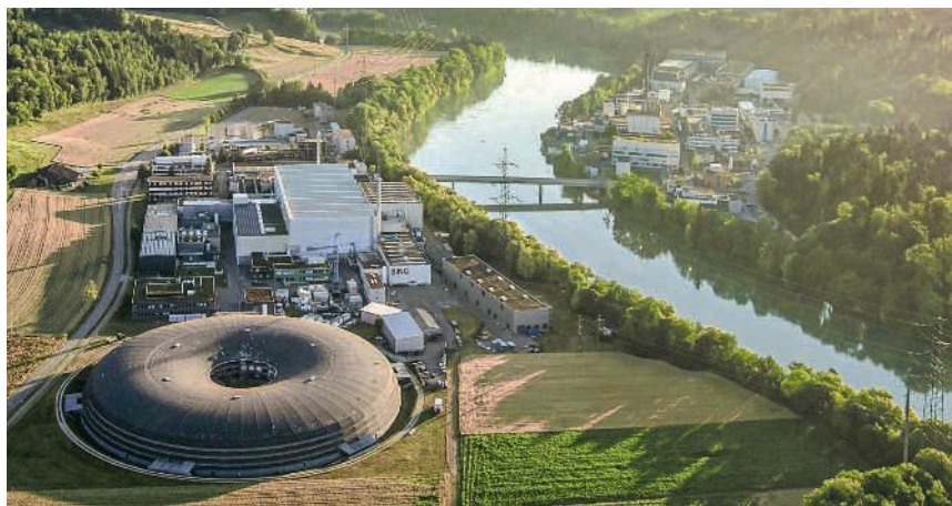
Das markanteste Gebäude des PSI: Die SLS ist kreisrund, entsprechend dem Elektronenspeicherring von 288 Metern Umfang, der darin verläuft
