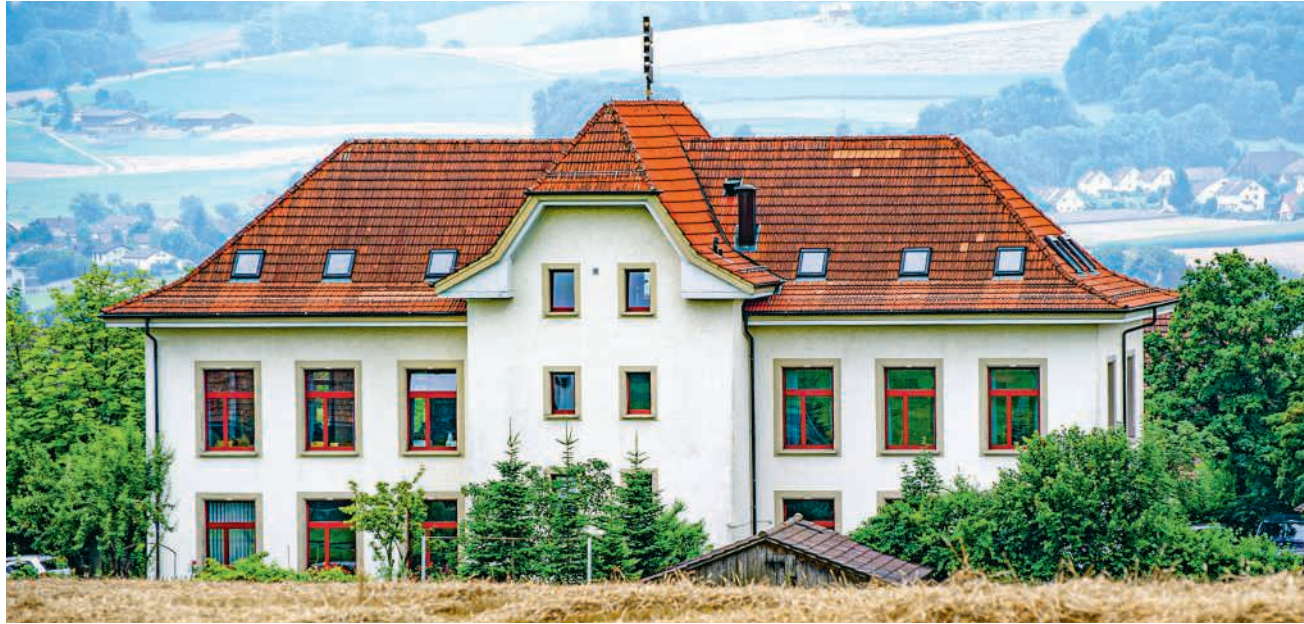
Das ehemalige Schulhaus von 1897, das heute vor allem die Gemeindeverwaltung beherbergt, soll nach dem Willen von Gemeinderat und Gemeindeversammlung für 2,1 Millionen Franken energetisch saniert werden, weiter sollen die Räume der Verwaltung barrierefrei werden
