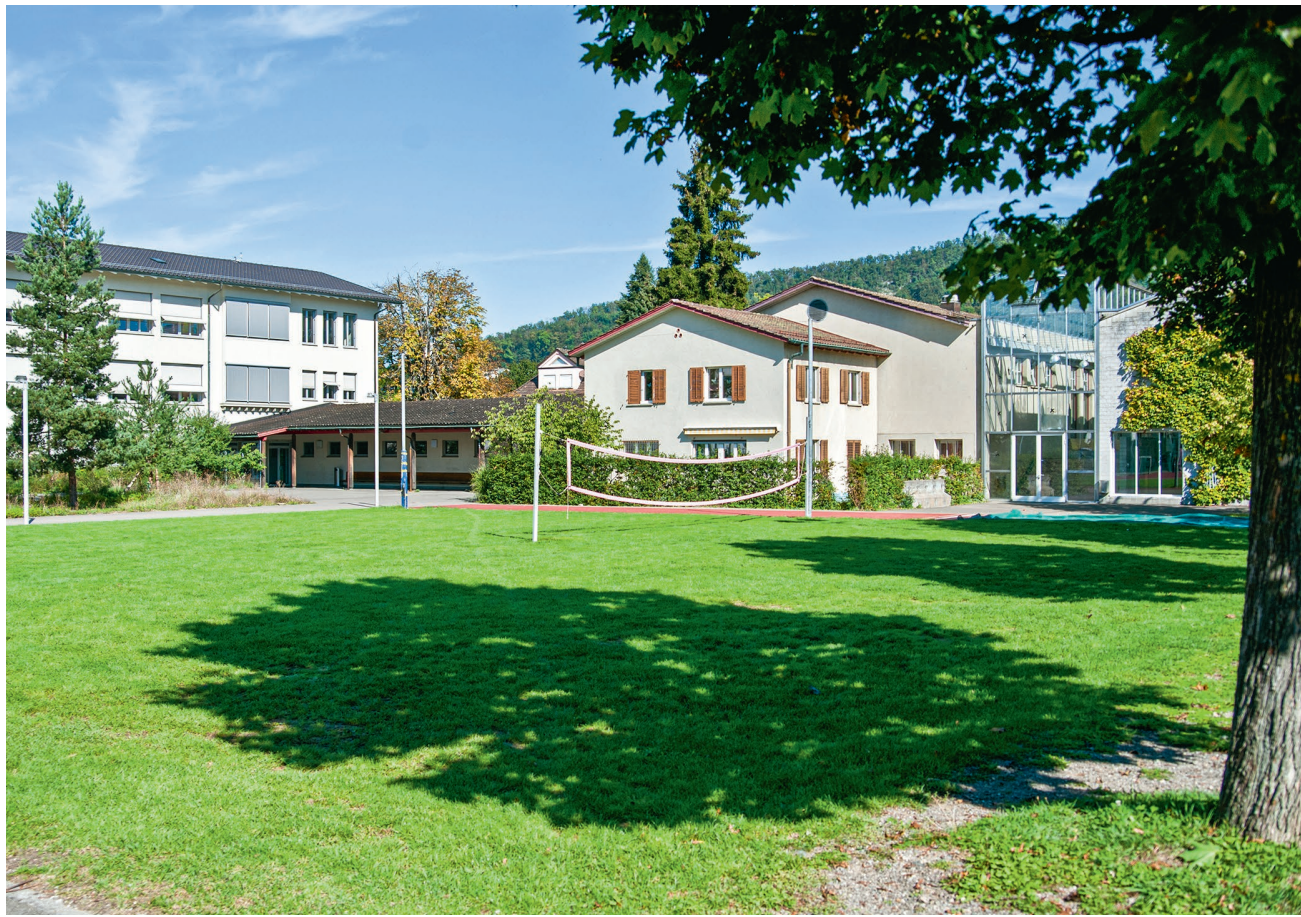
Auf der grünen Sportwiese der Schulanlage Altenburg sollen Container mit acht Klassenzimmern, vier Gruppenräumen und zwei Lehrerzimmern entstehen
