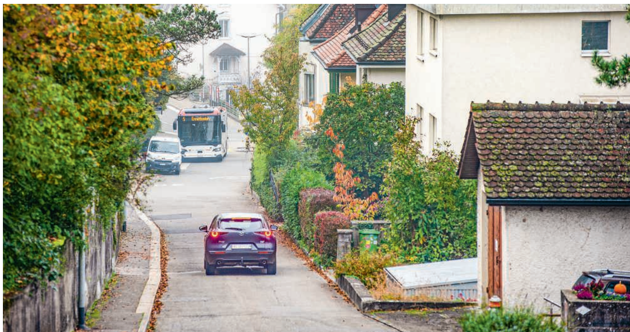
Die Grendelstrasse und mit ihr deren Werkleitungen sind in die Jahre gekommen. Die Gemeindeversammlung bewilligte ohne Gegenstimme insgesamt 695 000 Franken für eine Sanierung
