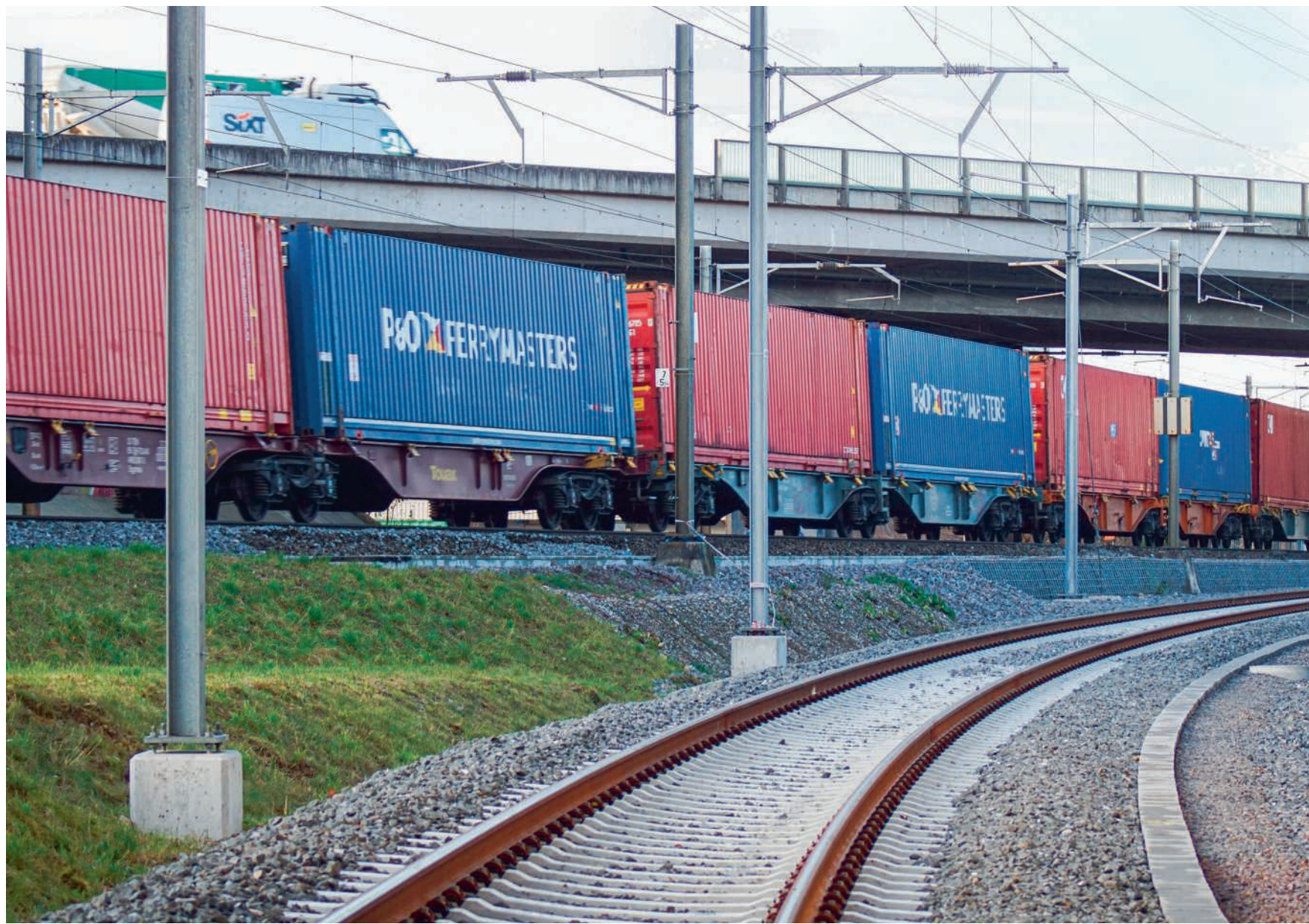
Die neue SBB-Verbindung Birr-Mägenwil zweigt bei Brunegg vom Südbahn-Trasse mit dem starken Güterverkehr ab und führt unter der Autobahn A1 sowie der Birrfeldstrasse durch zur Heitersberglinie
