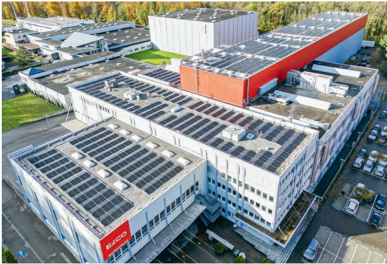
Ein bedeutender Schritt in Richtung grüner Zukunft: Die hochmoderne PV-Anlage der Elco AG
