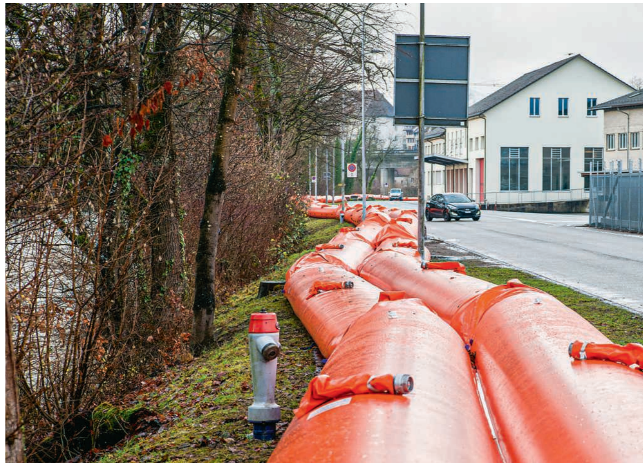
Orange Beaver-Schläuche schützen entlang der Ländstrasse in Brugg das Hinterland vor dem Hochwasser BILD: BKR
