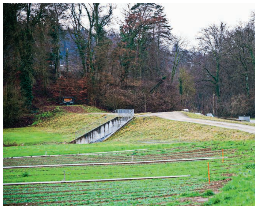
Im Surbtal hat man gegen Überflutungen Staustellen eingerichtet
