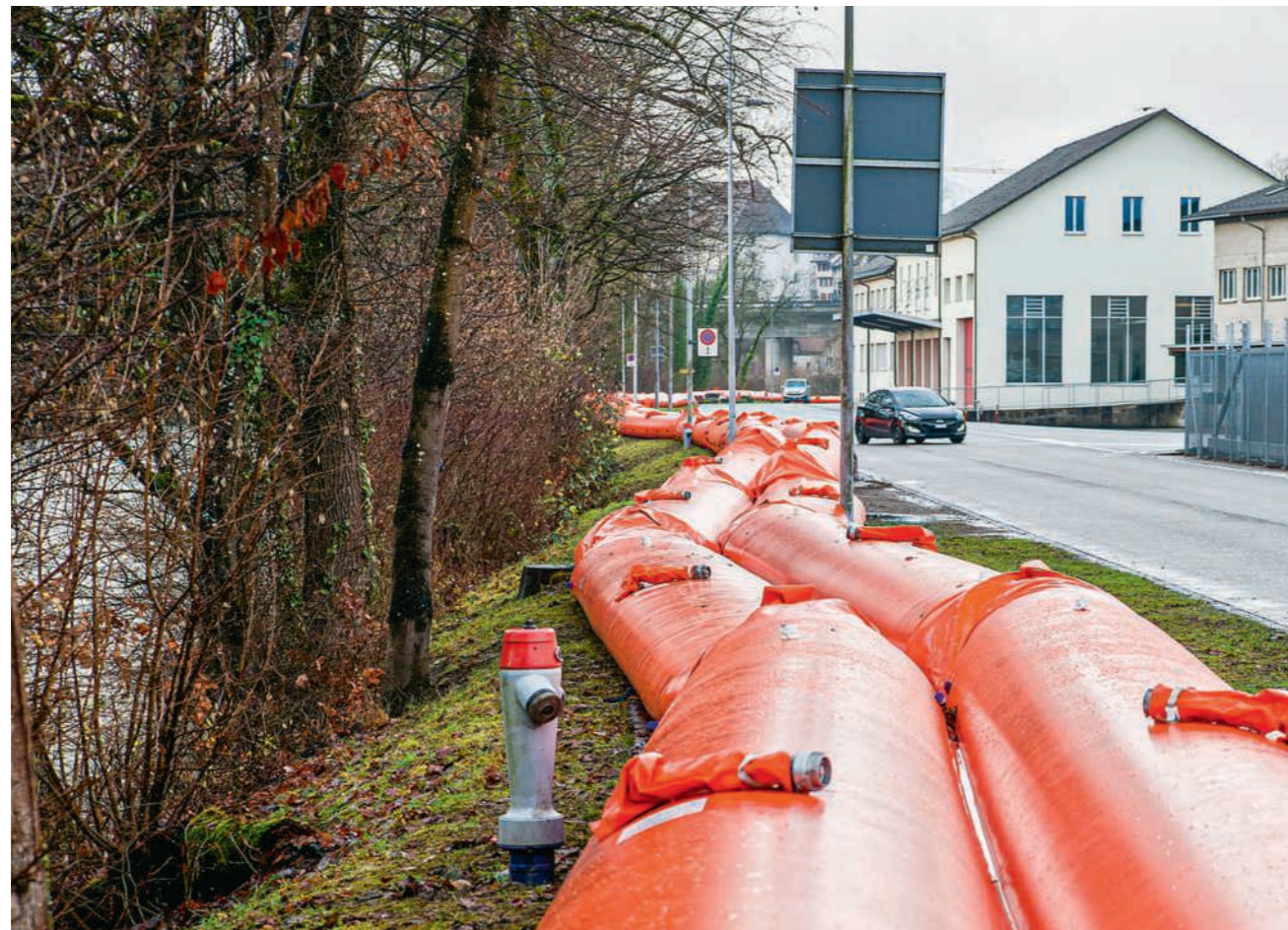
Orange Beaver-Schläuche schützen entlang der Ländistrasse in Brugg das Hinterland vor dem Hochwasser
