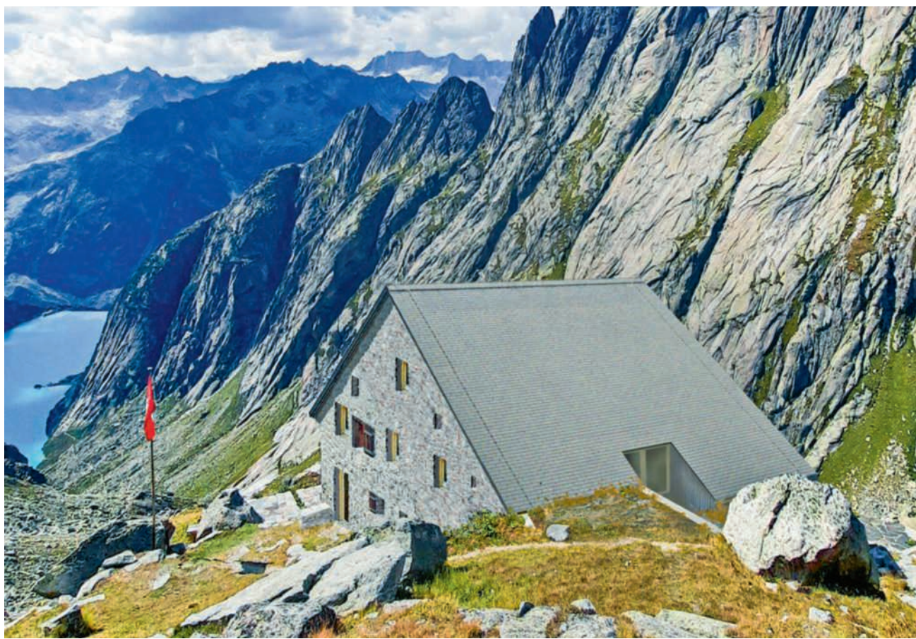
Visualisierung der neuen Gelmerhütte. Das Dach ist im Fels verankert und dient gleichzeitig als Lawinenschutz
