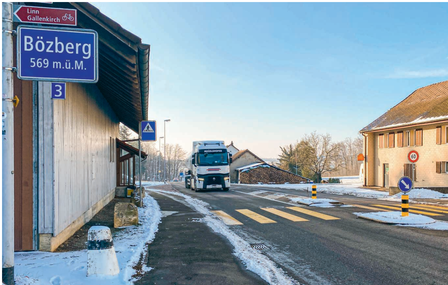
Die Bözbergstrasse ist weniger befahren als früher, aber der Strassenbelag ist in die Jahre gekommen und wird jetzt saniert, und der Veloverkehr erhält eine markierte Spur
