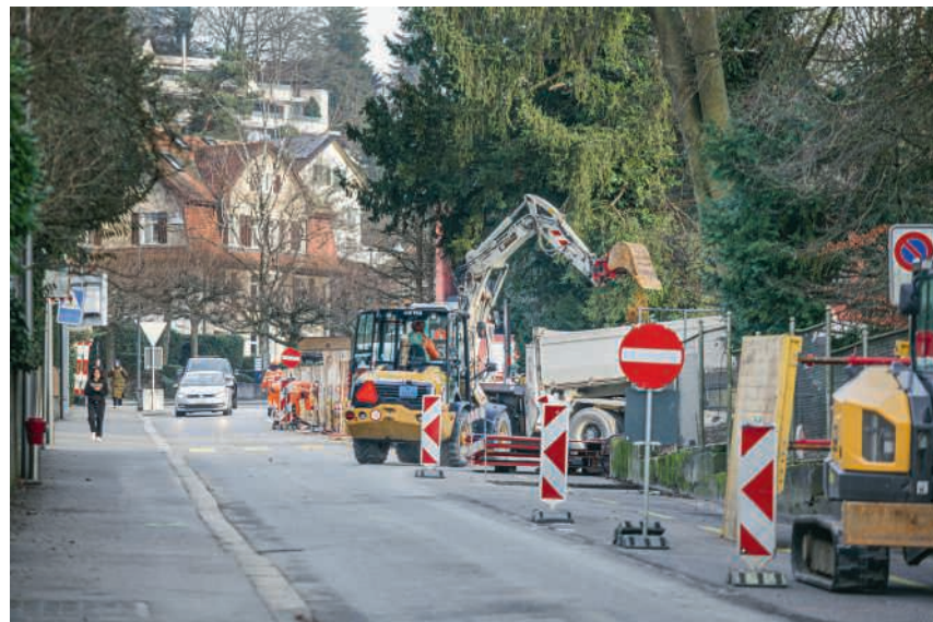
Die Baustelle an der Schartenstrasse hat Staus zur Folge
