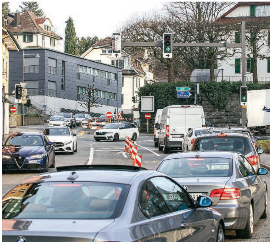
Der Flaschenhals bei der Baustelle an der Scharthenstrasse in Baden sorgt täglich für lange Wartezeiten
