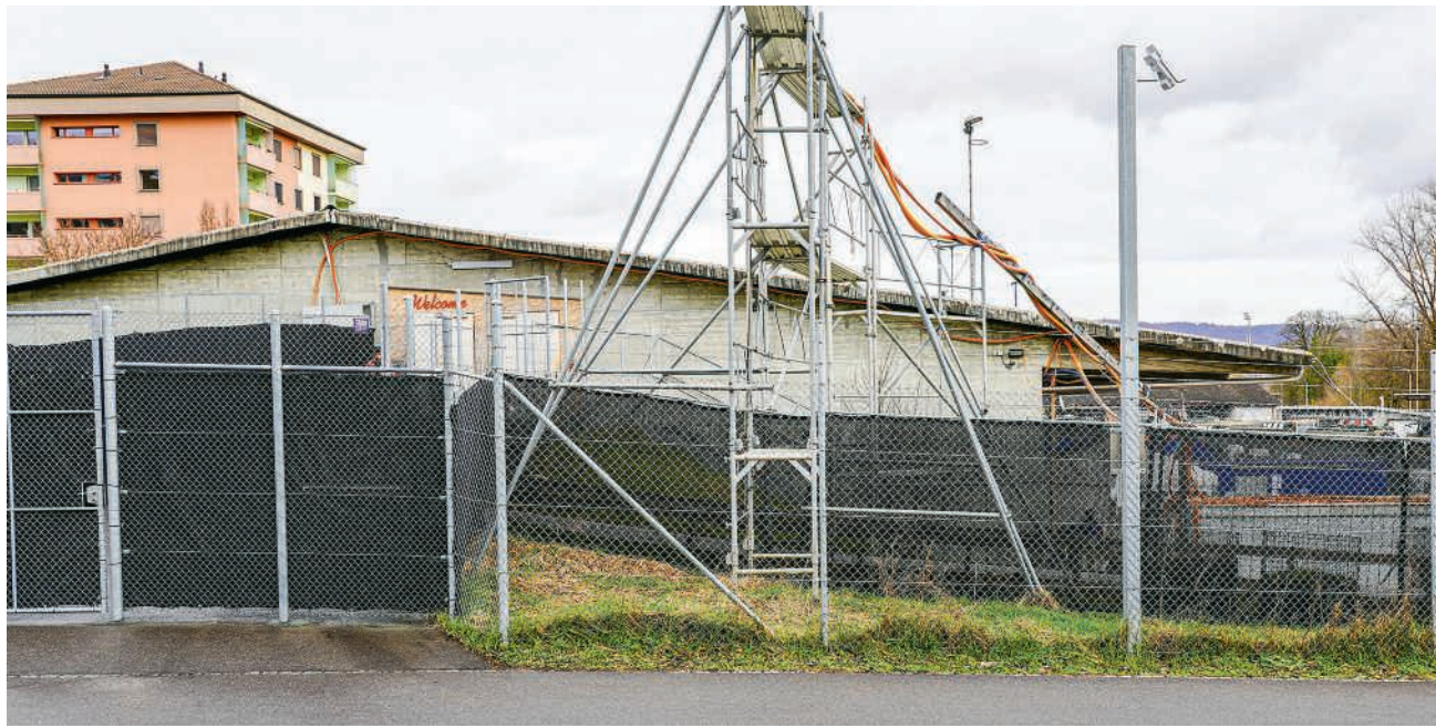
Das Bundesasylzentrum befindet sich in einer ehemaligen Halle für Militärfahrzeuge des Waffenplatzes
