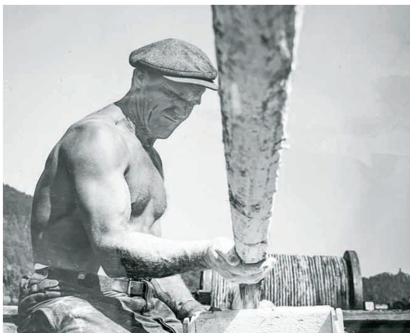
Fachmännische Kabelabwicklung bei einer Seeverlegung am Thunersee BILD: ZVG
