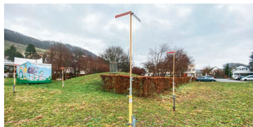
Bauprofile auf der Wiese an der Rebhaldenstrasse für das Provisorium
