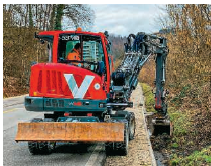
Die Amphibienleitanlage entlang des Dättwiler Weihers wird gereinigt BILD: ZVG
