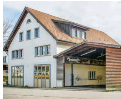
Das Gebäude des SVLT
