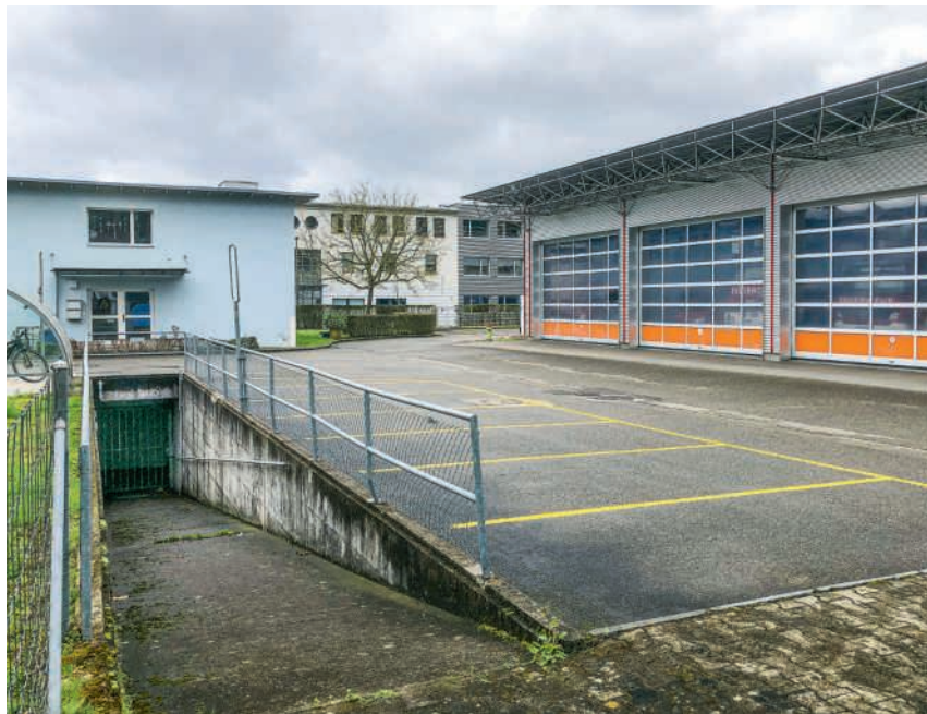
Abgang zur Zivilschutzanlage beim Technischen Zentrum, Nussbaumen BILD: MPM
