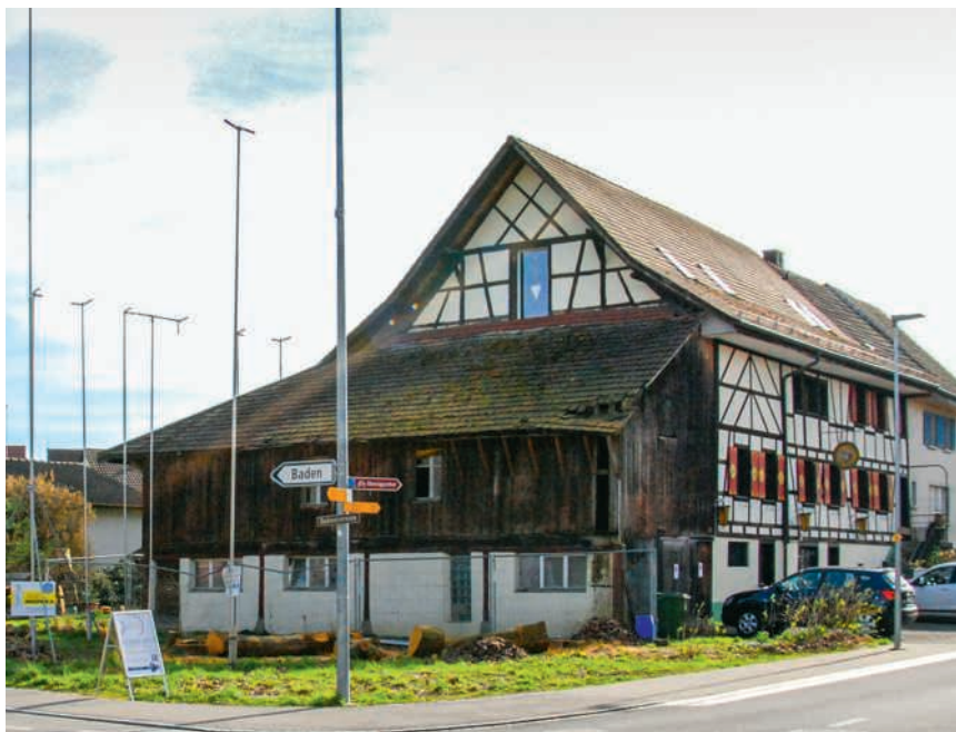
Vorher: Auf diesem Spickel ist der Neubau geplant
