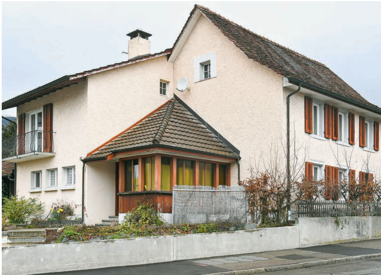
Die dem Abbruch geweihte Liegenschaft an der Dorfstrasse 25 in Wettingen. BILD: PG
