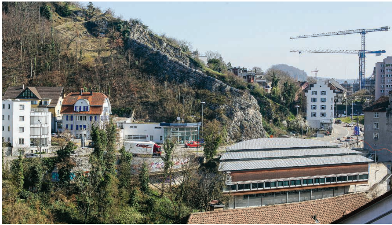
Eine Schlüsselstelle für den Verkehr im Raum Baden ist der südliche Knotenpunkt zwischen Ennetbaden und Baden BILD: SIM
