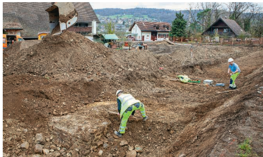
Beim Voraushub kam erneut ein massives Mauerfundament zum Vorschein
