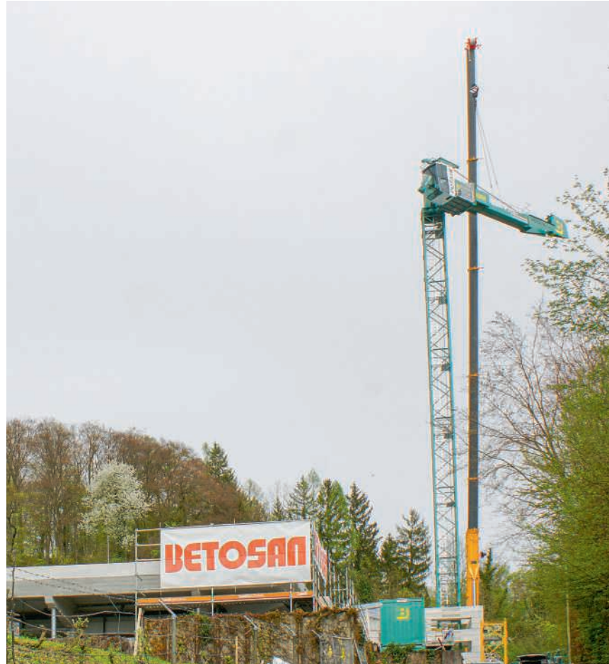
Mit dem Turmkran gelangen die Arbeiter in schwindelerregende Höhen BILD: PG
