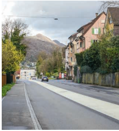
Die Bauvorhaben an der Mellingerstrasse liegen auf Eis
