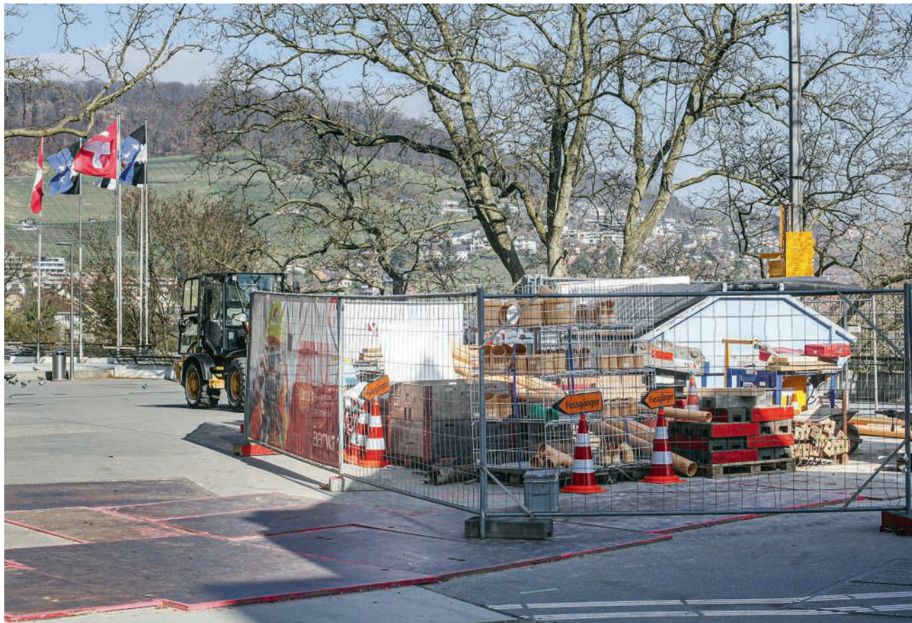
Vom unteren Bahnhofplatz werden die Fernwärme- und Fernkälteleitungen bis zum Schlossbergplatz verlegt
