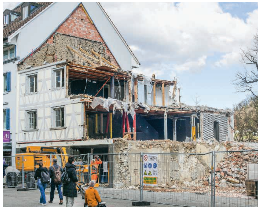
Liegenschaften an der Badstrasse werden rückgebaut
