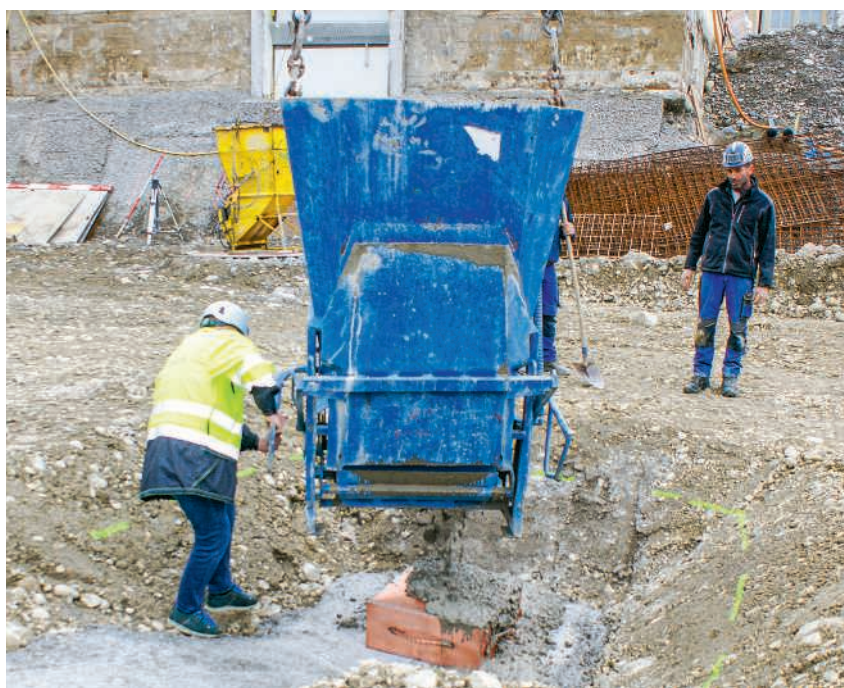
Reto von Allmen übergiesst die Zeitkapsel mit Beton
