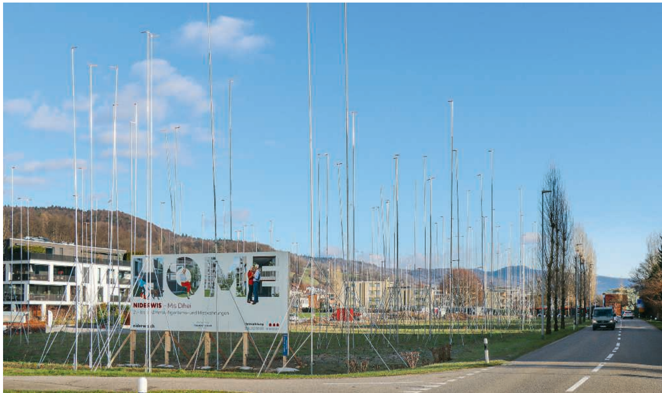
Die Bauprofile an der Landstrasse von Westen aus
