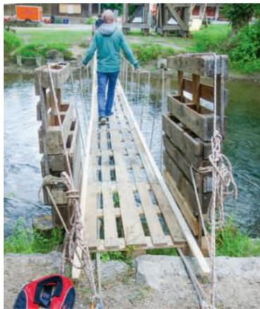
Titananker, Seile und Paletten: Diese Notbrücke entstand in 90 Minuten
