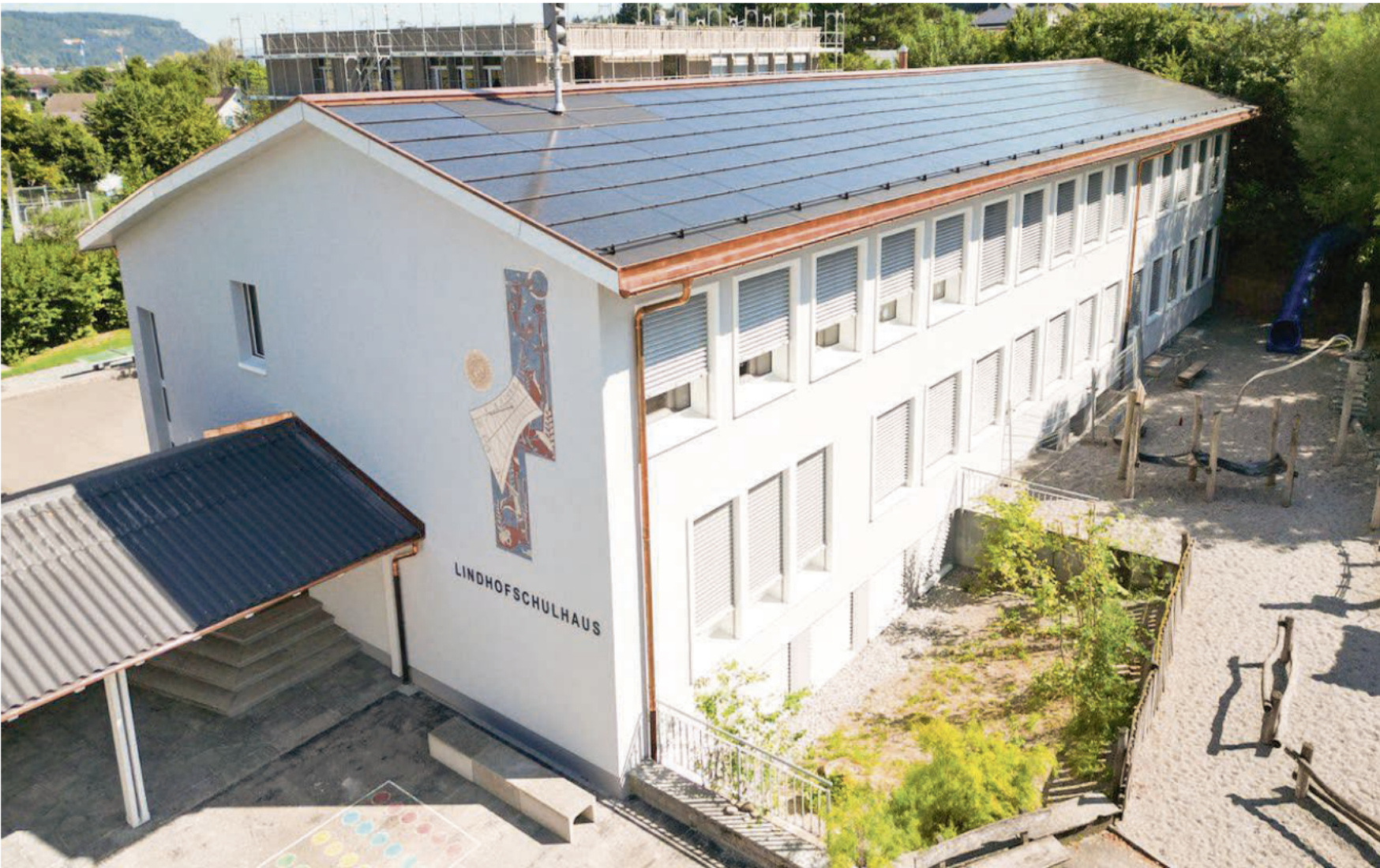
Das sanierte Lindhofschulhaus hat eine besser isolierte Fassade und ein neues Solardach BILD: HPW
