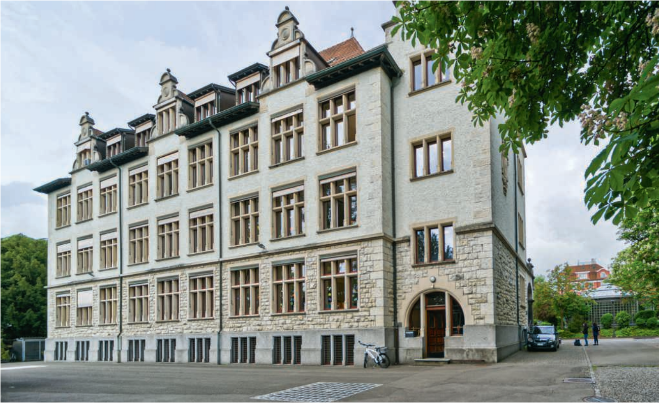
Das Schulhaus Ländli in Baden soll sanft erneuert werden
