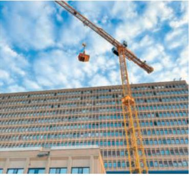
Kran mit Stromrückgewinnung BILD: ZVG
