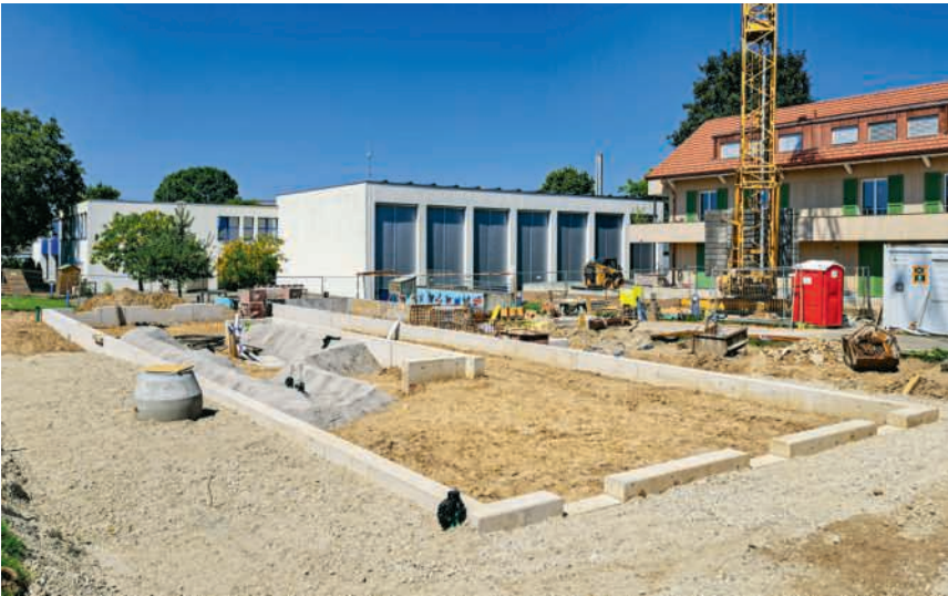
Hier entsteht der Neubau der Schule Leematten
