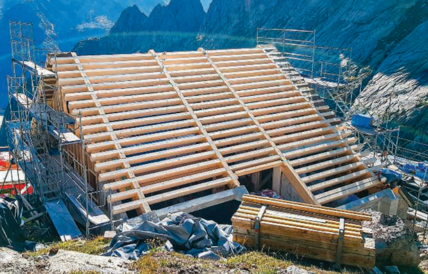
Die Gelmerhütte der SAC-Sektion Brugg steht
