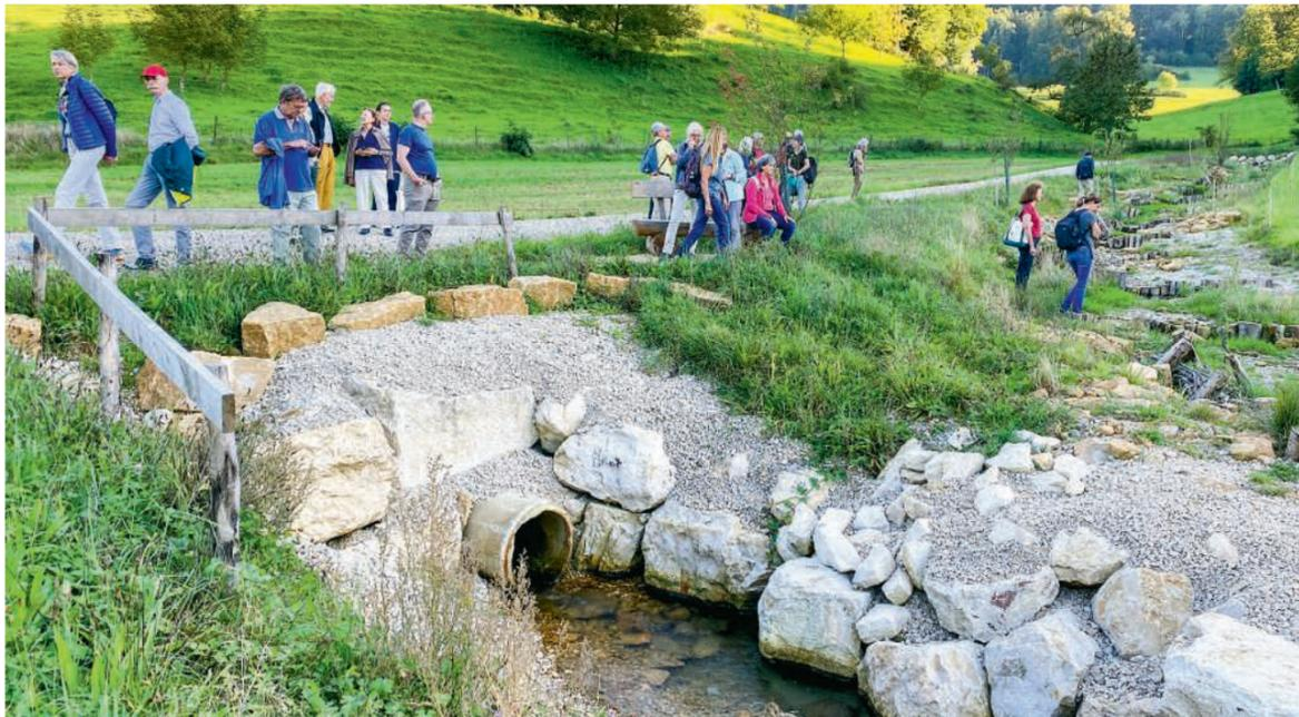
Im oberen Teil des Sagemültälis wurde der streckenweise kanalisierte Mülibach wieder ausgegraben und im offenen Bachbett revitalisiert
