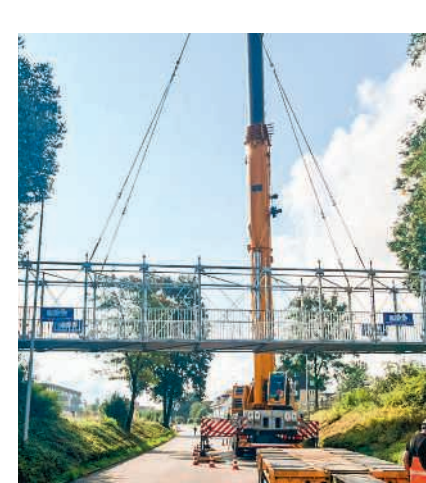
Einbau der Ersatzbrücke Boostocksteg
