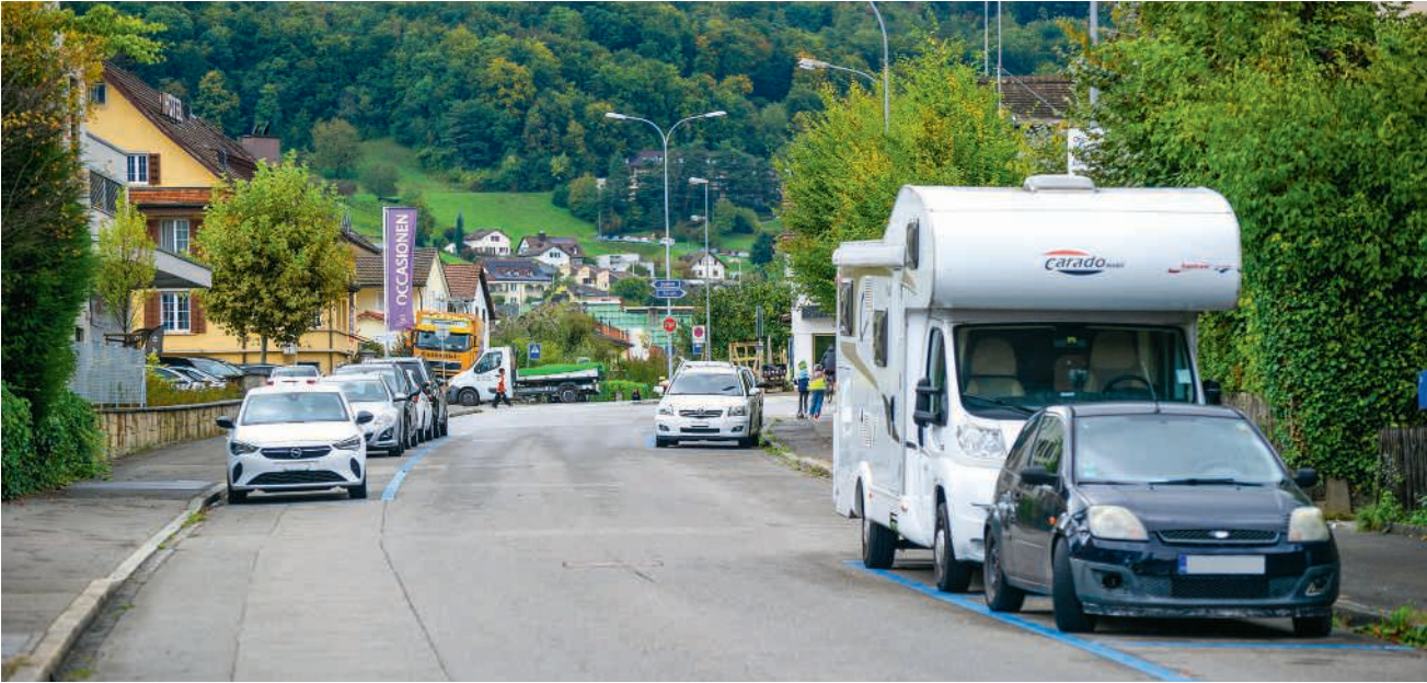
Insgesamt 2,611 Millionen Franken kosten Sanierung und Umbau der Jurastrasse samt neuen Leitungen
