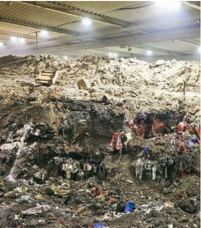
Die von Beginn an umstrittene Sondermülldeponie in Kölliken musste aufwendig saniert werden
