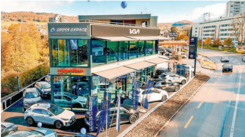
Vierter Standort der Gross-Garage in Baden
