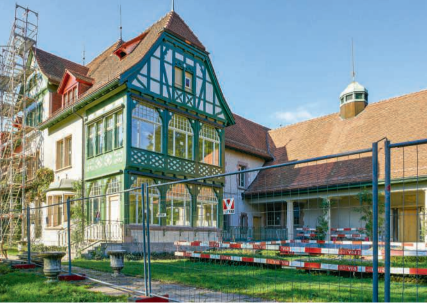
Museum Langmatt: Saniertes Holzfachwerk und Dach im Oktober BILD: ERWIN AUF DER MAUER
