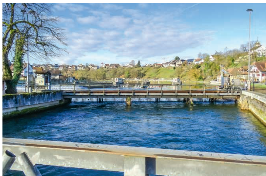
Das Axpo-Kleinkraftwerk braucht eine hindernisfreie Fischpassage
