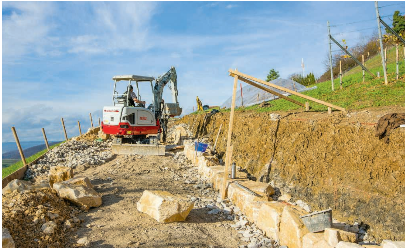
Im Rahmen des Jurapark-Projekts sind mehrere Trockenmauern saniert worden
