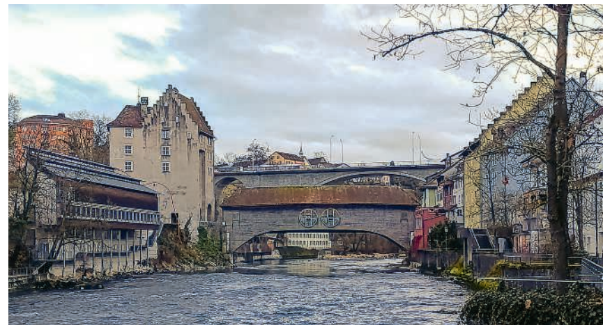
Ab Anfang Februar wird die Holzbrücke saniert BILD: SIM
