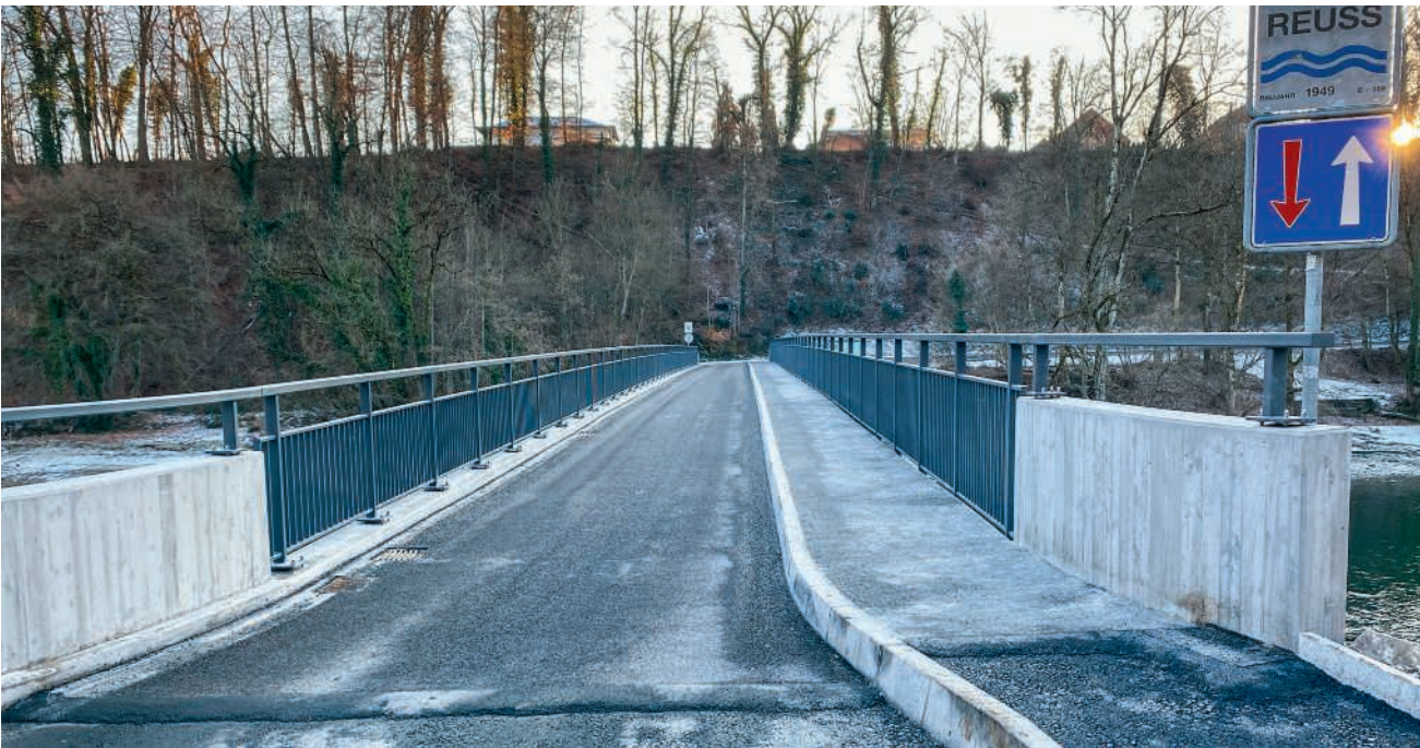
Die Reussbrücke hat ihre ursprüngliche Breite von vier Metern behalten – aber sie ist erdbebensicherer gemacht worden und hat ein neues Geländer bekommen
