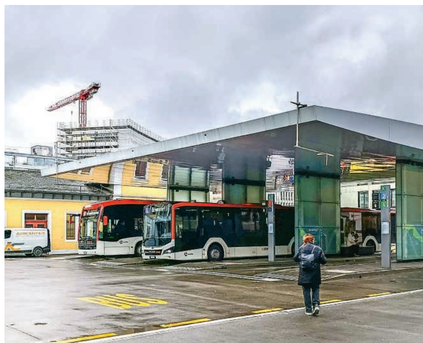
Elektrobusse sollen hier künftig geladen werden können
