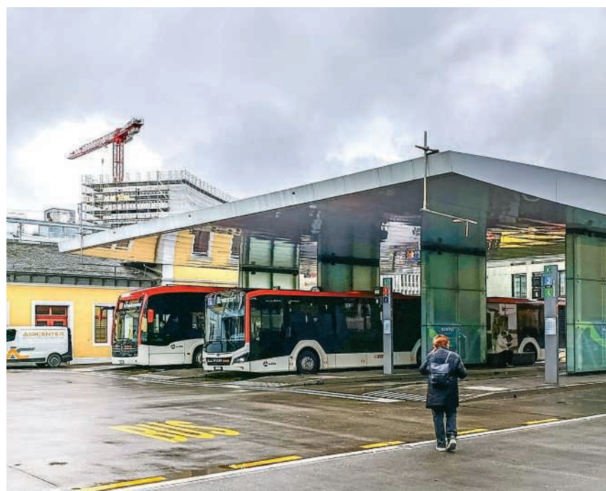
Elektrobusse sollen hier künftig geladen werden können
