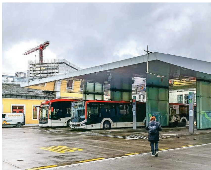
Elektrobusse sollen hier künftig geladen werden können
