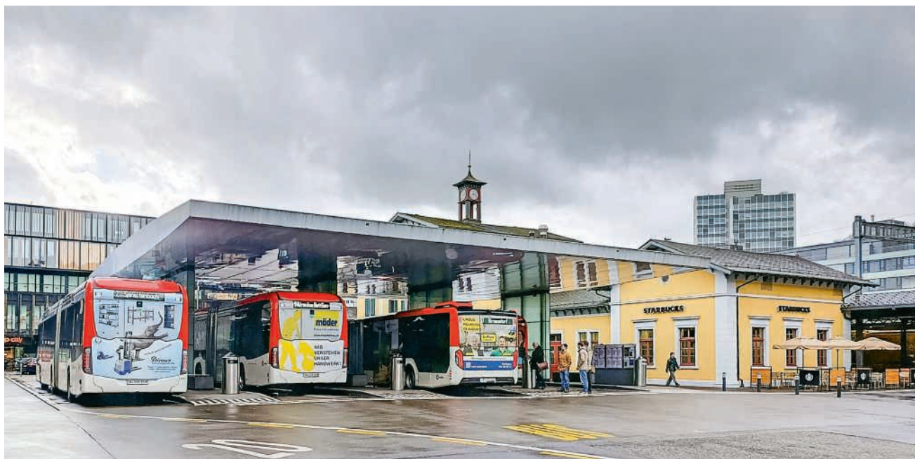
Die heutige Haltestelle Baden Bahnhof Ost entspricht nicht den Vorgaben des Behindertengleichstellungsgesetzes BILD: SIM
